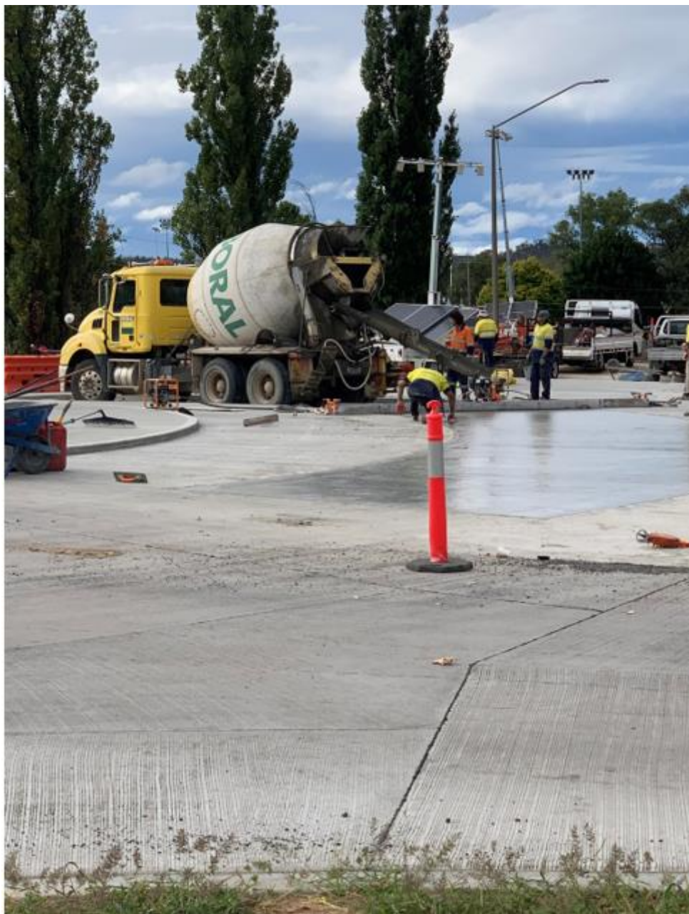
Final pour for the concrete pavement
